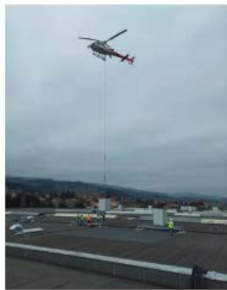
Héliportage d'un rafraîchisseur en toiture.
