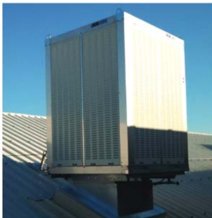
Rafrâchisseur Aerdimol® installé en toiture de bâtiment.
