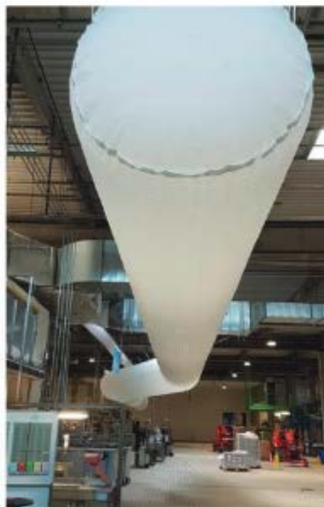
Diffusion de l'air par gaine textile.
