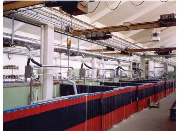
... pour le soudage de structures de camions
