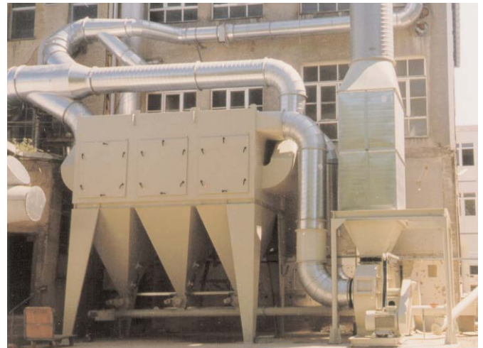
Centrale de filtration dans le domaine de l'émaillage
